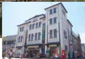
スーベニール小樽館（旧戸出物産小樽支店）
