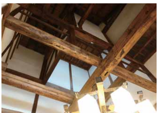
梁の上には望楼からの明かり
