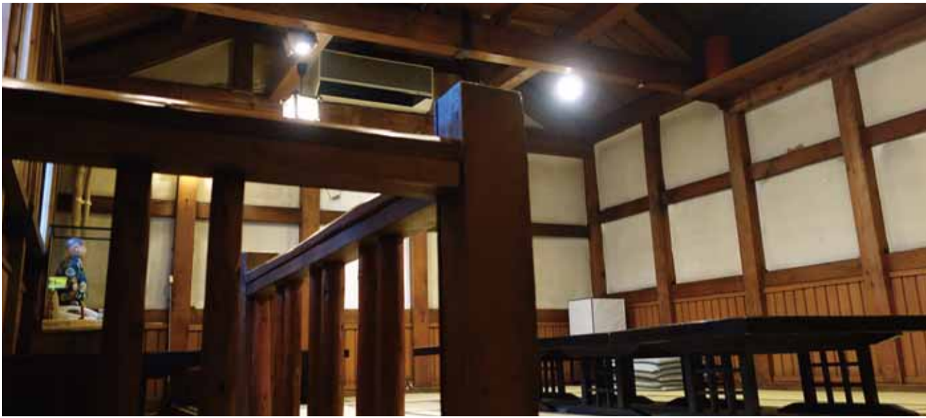
石蔵2階の堅牢な梁
