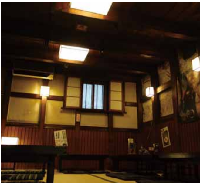
石壁・漆喰壁・腰板の三拍子
