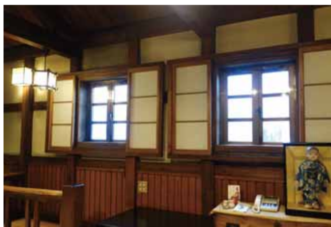
石蔵2階の漆喰壁と障子
