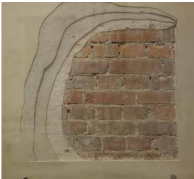
内壁はレンガの表面に漆喰を4層塗り
