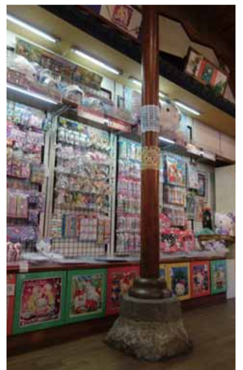
石の基礎に建つ鉄柱は創建時から
