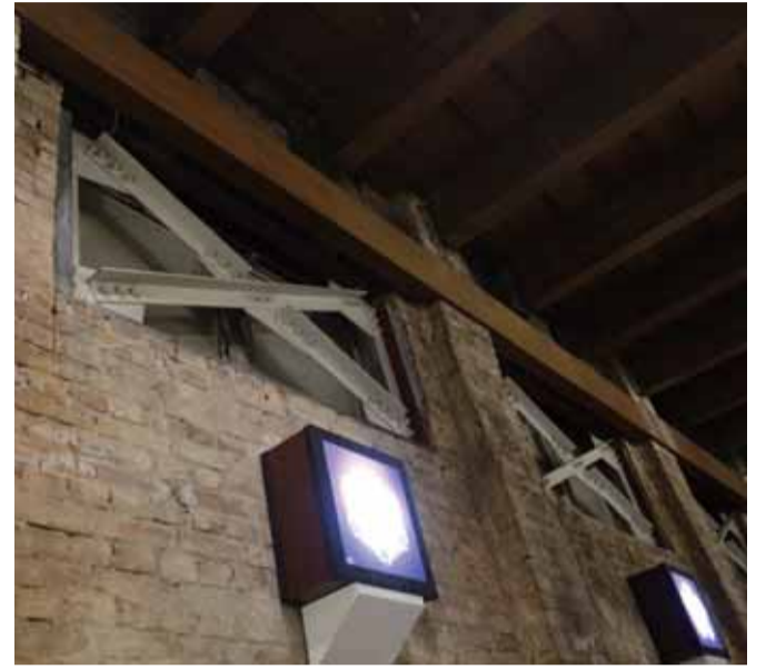
窓枠の鉄骨補強
