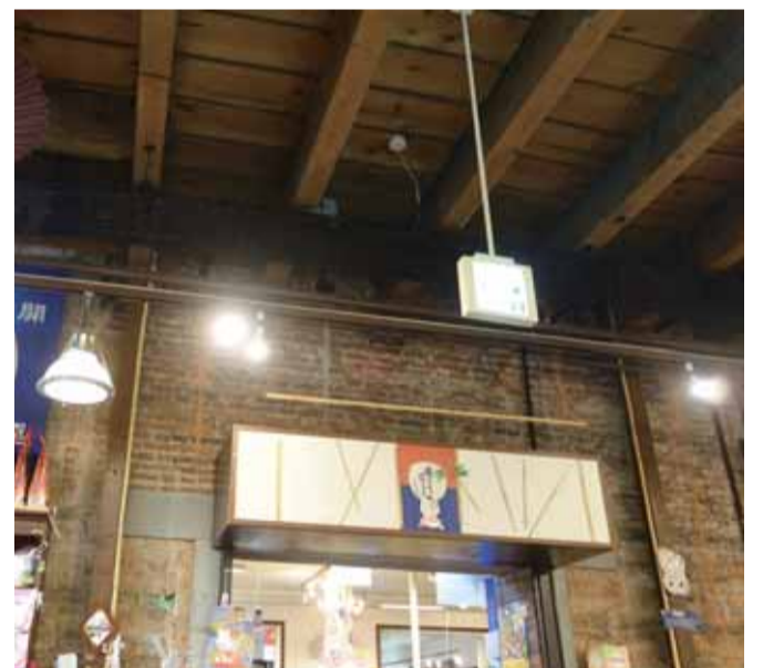
煉瓦倉庫の壁と天井を生かす
