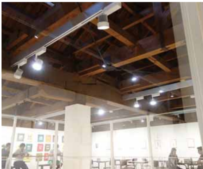
鉄骨で吹き抜け補強
