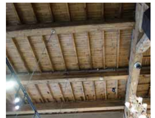
吹き抜けの梁と天井
