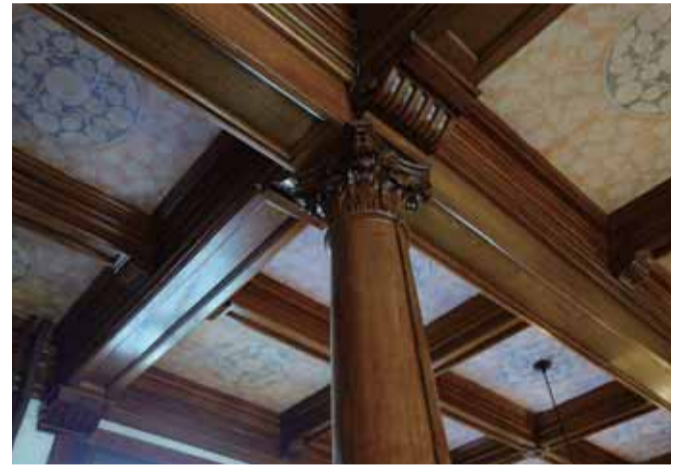
1階天井と柱の装飾
