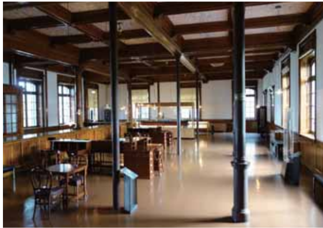
鉄柱と格天井の1階フロア
