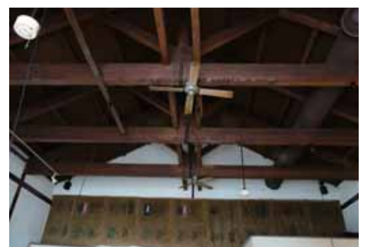
梁とダクトの素朴なコントラスト
