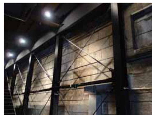
鉄骨補強のロビーと楽屋階段
