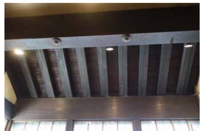
梁をオイルステン塗り
