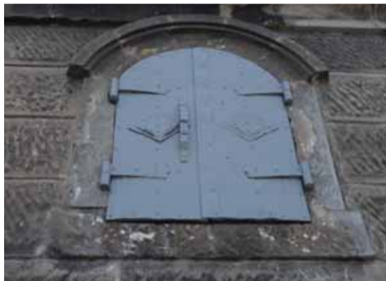
重厚な鉄製窓扉
