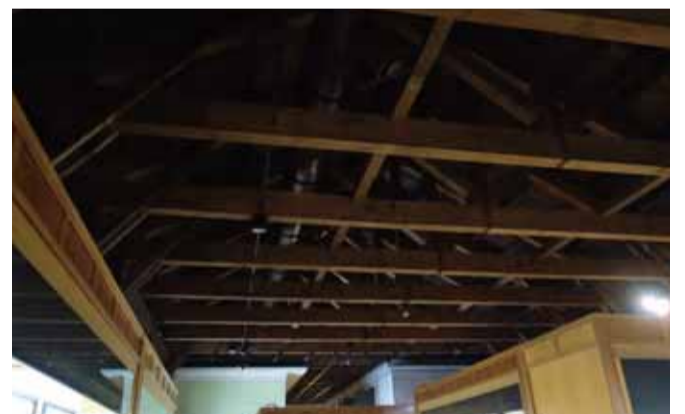
梁・配線・ダクト
