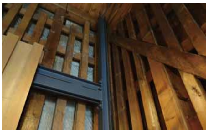
柱と梁補強
