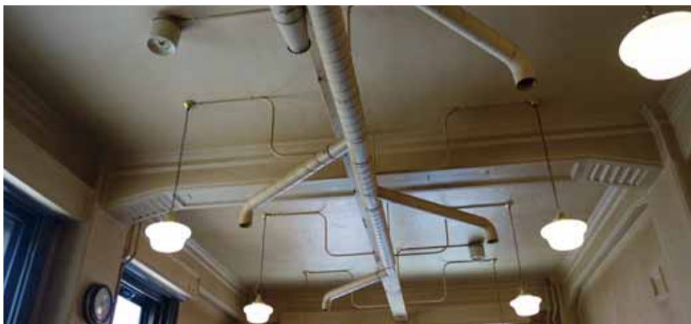
ダクトと配線の妙
