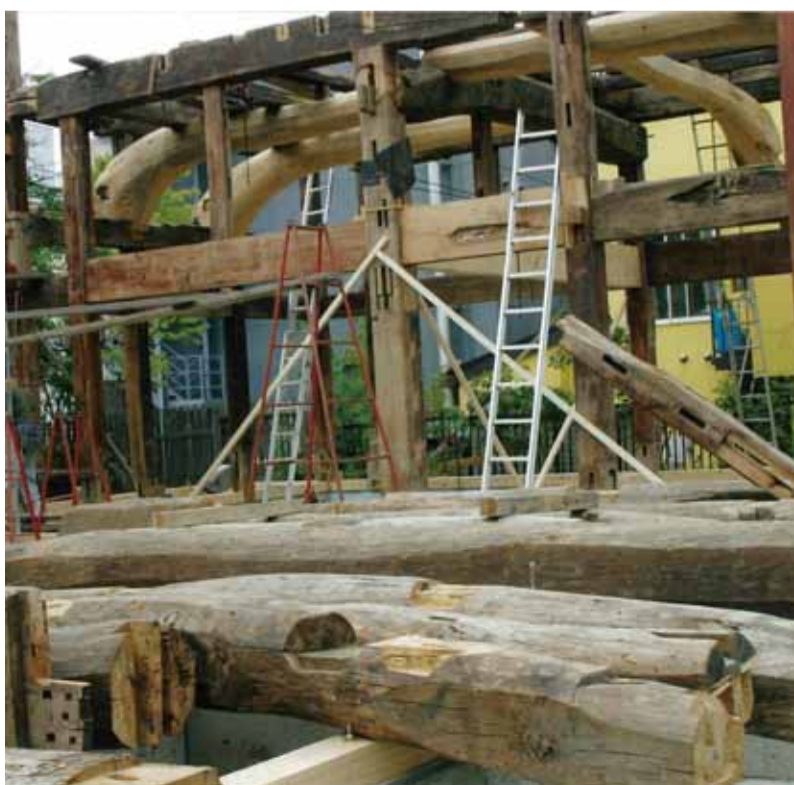
マオイ酪農会館解体工事
