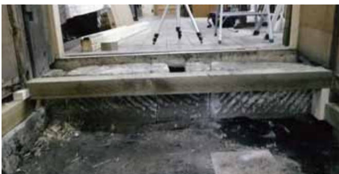
不老館石蔵補修
