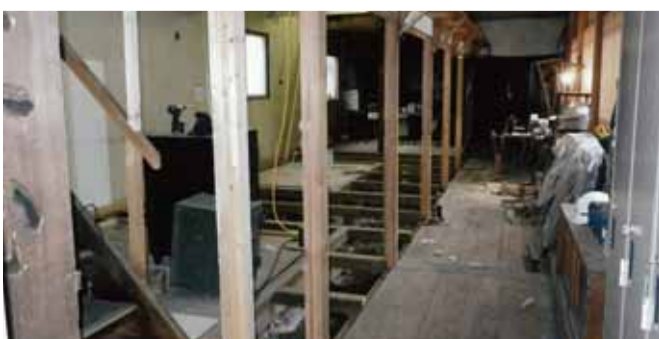
廊下連結工事
