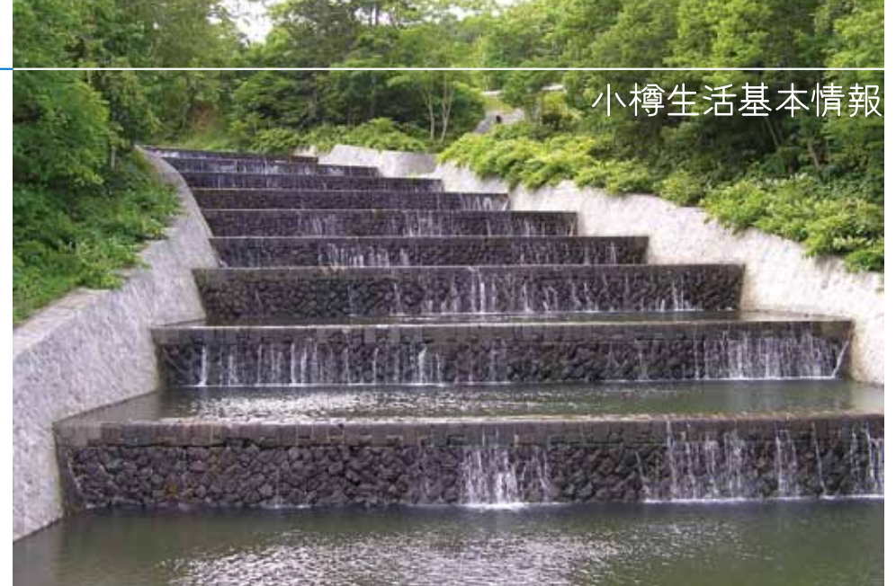
奥沢水源地 階段式溢流路 いつりゅうろ
