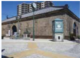
小樽運河プラザ (元 小樽倉庫)
